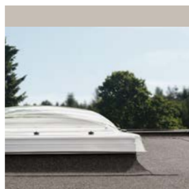
Světlík s kopulí a zasklením
